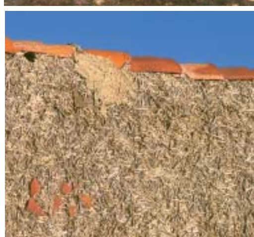
Los muros de adobe y tapijal suelen estar enlucidos con una mezcla de barro y paja, capa que se pierde con el tiempo en las construcciones abandonadas.
